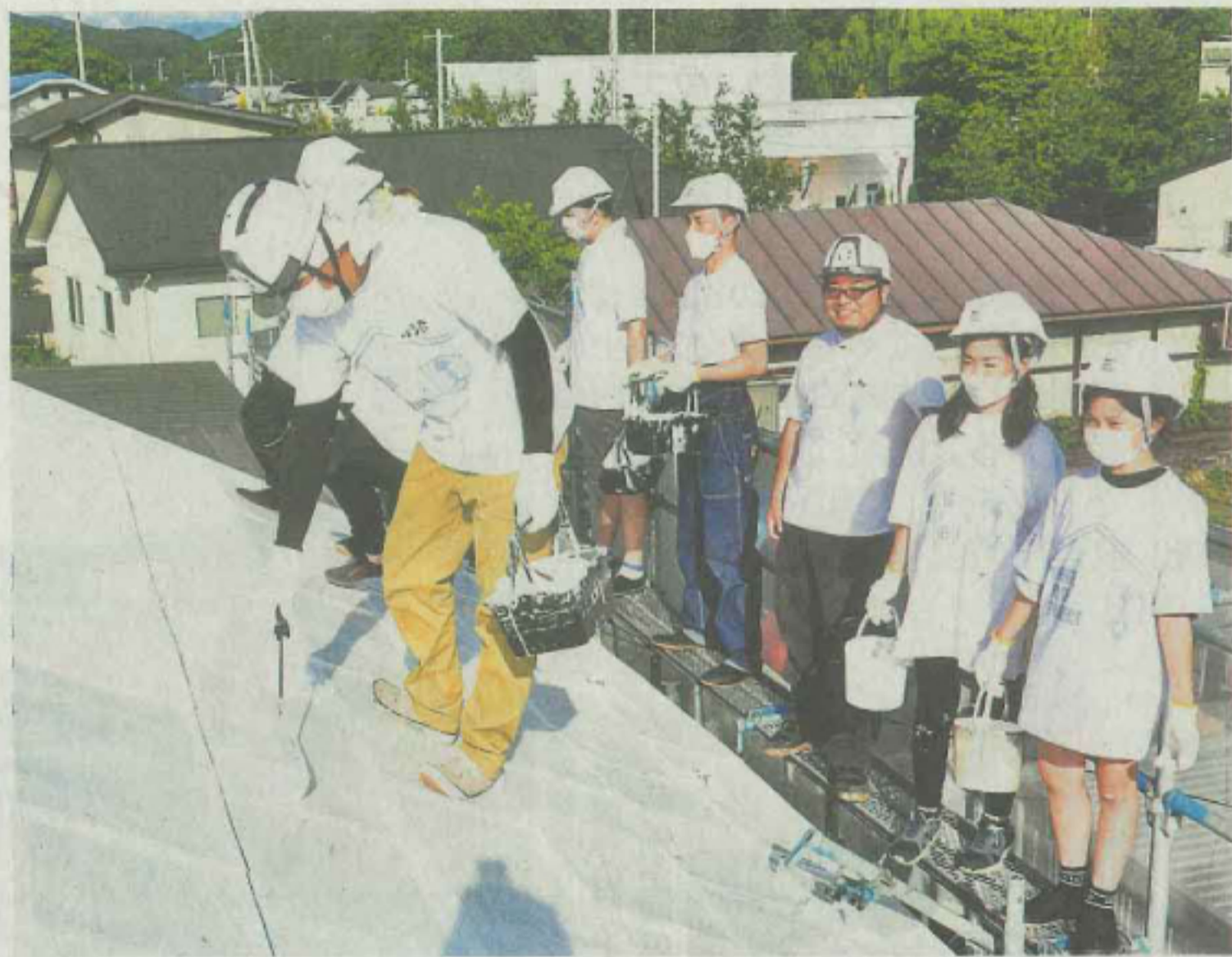
山岸児童クラブの屋根にガイナ塗料を塗るボランテ ィアら。断熱効果が高く、夏の暑さを緩和できる
