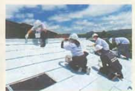
学童クラブの屋根に塗料を塗る様子
