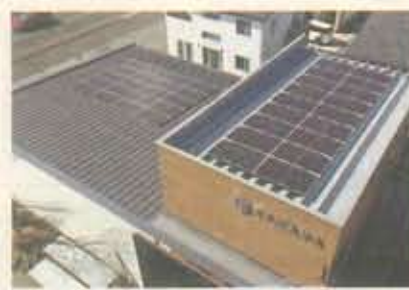
社屋の屋根に設置した太陽光パネル
